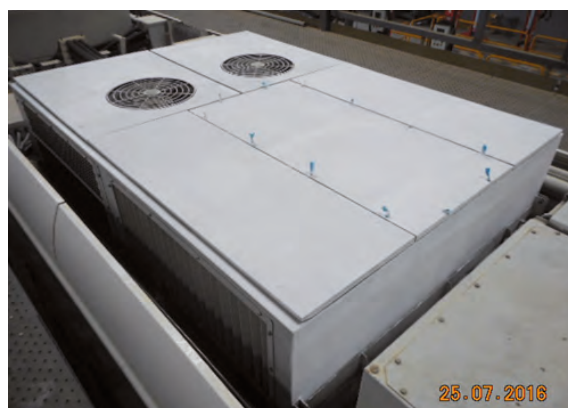
Unidad Siemens de la serie 3800 con pintura térmica de recubrimiento reflectante.
