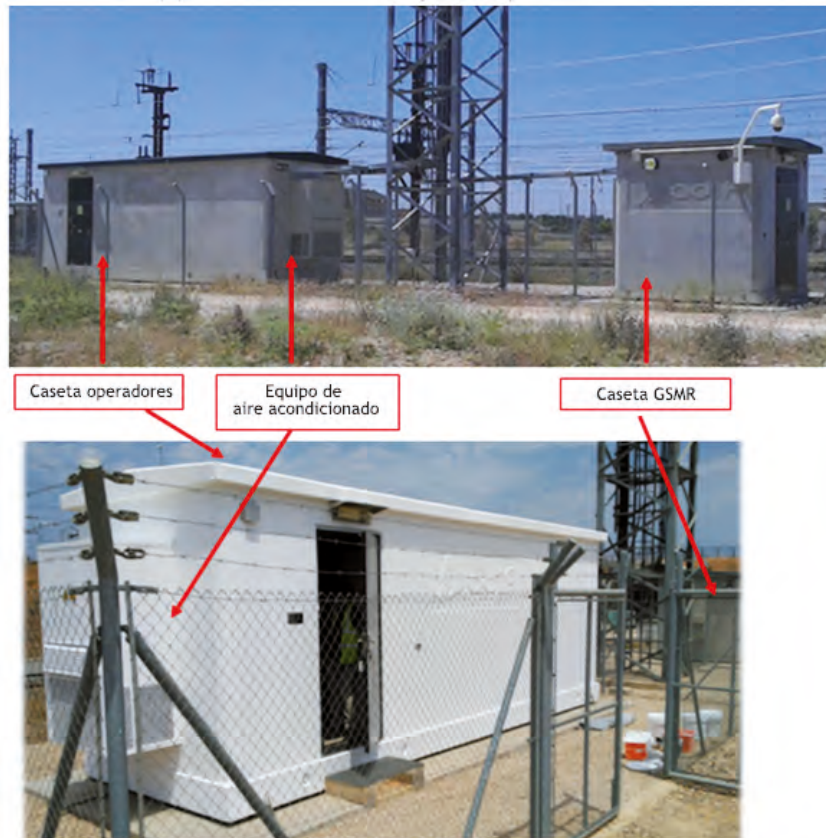
Caseta de operadores en boca túnel lado Madrid PK385+100
