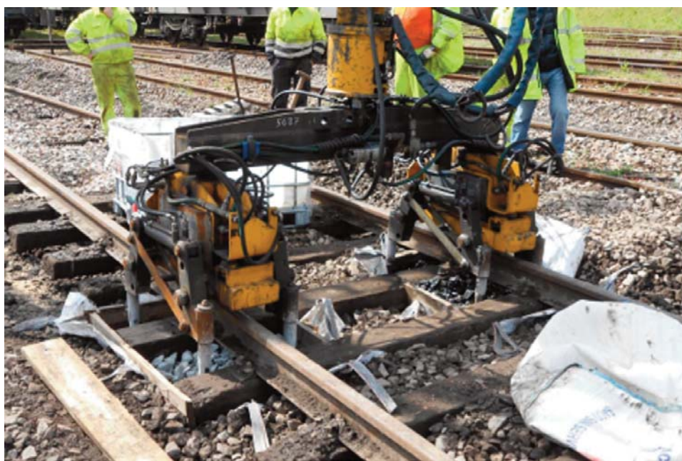
Figura 9. Grupo de bateo Vaiacar V704 F+ en funcionamiento (50 Hz)
