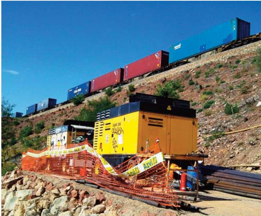
Fotografía 3. Vista del terraplén con tráfico de mercancías durante la realización de los trabajos
