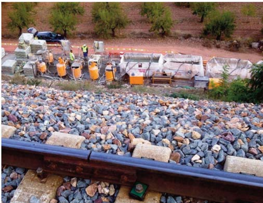
Fotografía 1. Planta de inyección y depósitos de reciclado de agua.
