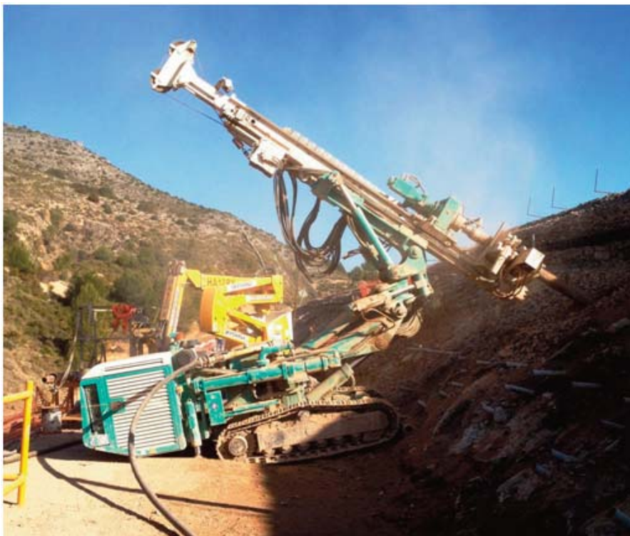
Fotografía 4. Trabajos de perforación en el terraplén.
