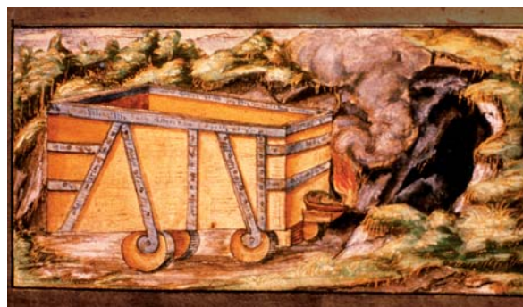
Fig. 12. Perro de mina a la entrada del socavón, según el Schwazer Bergbuch (1556). En la parte delantera va situada una lámpara de aceite para el alumbrado. (Tiroler Landesmuseum Ferdinandeum, Innsbruck).
