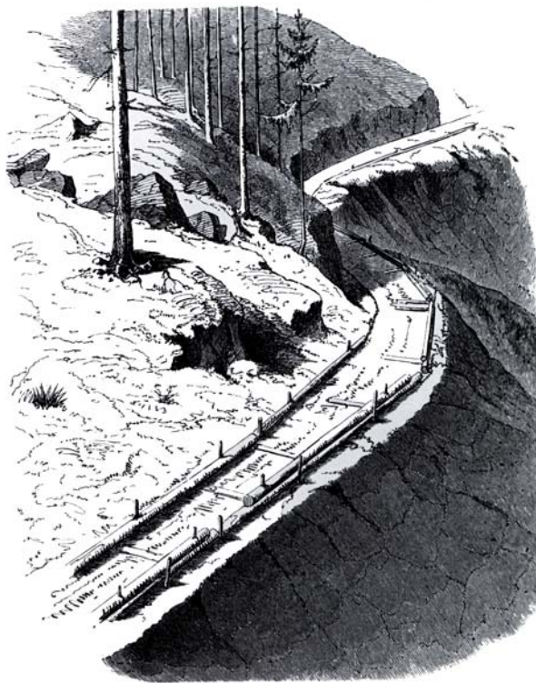
Fig. 51. Un camino lanzadero forestal, según Gayer (1863). (Escuela Técnica Superior de Ingenieros de Montes).
