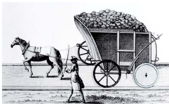
Fig. 81. Vagón utilizado en los caminos de Newcastle, según Jars (1763). (Escuela Técnica Superior de Ingenieros de Minas).
