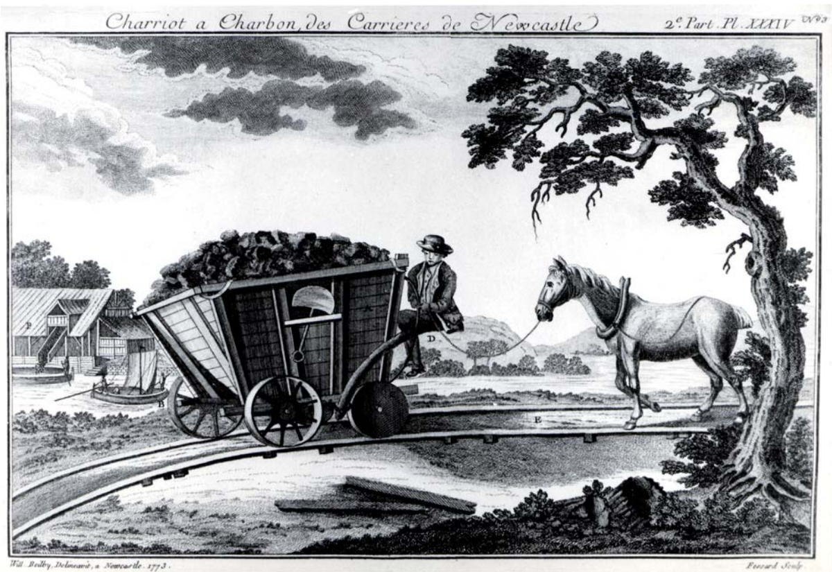
Fig. 76. Camino de madera de Newcastle, según Morand (1773). En la parte izquierda se ve la descarga del carbón, desde el cargadero a la barcaza. (Escuela Técnica Superior de Ingenieros de Minas).
