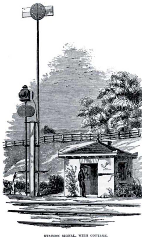
Fig. 308. Nada más iniciarse la explotación ferroviaria hubo que garantizar la seguridad de la circulación con un sofisticado sistema de señales. (Archivo RENFE).
