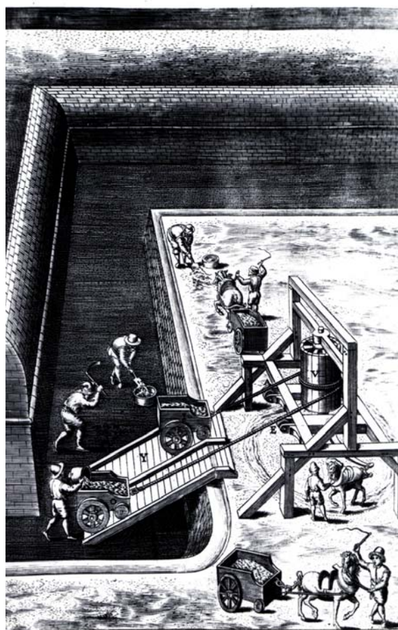
Fig. 33. Máquina para transportar tierra con la sola fuerza de una caballería, según Romelli (1588). (Biblioteca Nacional).
