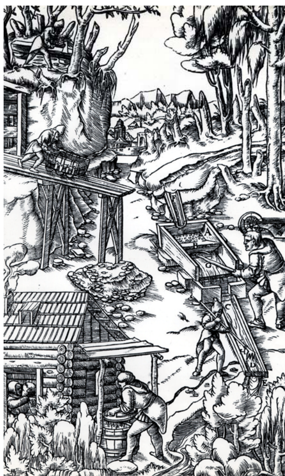
Fig. 25. Descarga del mineral en bocamina y operaciones de lavado, según G. Agrícola (1556). A: Caja. B: Placa perforada. C: Pileta. D: Tablas transversales. E: Balsa. F: Artesa. G: Pala. H: Rastrillo. (Biblioteca Nacional).
