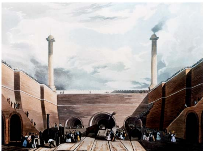
Fig. 205. La estación de Edge Hill. Grabado de T. T. Bury (1831). El túnel central, denominado Wapping, descendía hasta el puerto de Liverpool. El túnel de la derecha, denominado de Crown, descendía hasta la terminal de viajeros situada en la calle de este nombre. El túnel de la izquierda era ciego y no tenía otro objeto que armonizar la construcción. (National Railway Museum, Inglaterra).
