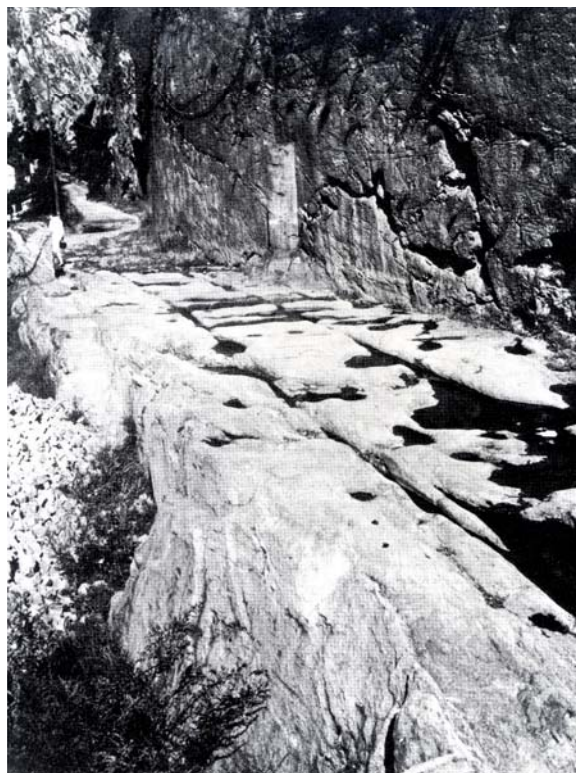
Fig. 4. Rodadas labradas a propósito en la calzada romana del valle de Aosta, según R. Chevalier (1972). (Biblioteca Nacional).
