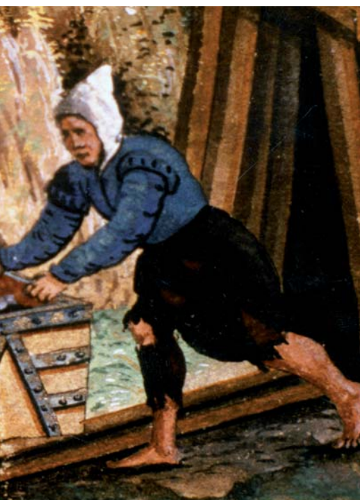
Fig. 13. Perro de mina a la salida del socavón, según el Schwazer Bergbuch (1556). El conductor levanta las ruedas delanteras para reducir el esfuerzo de tracción. (Tiroler Landesmuseum Ferdinandeum, Innsbruck).
