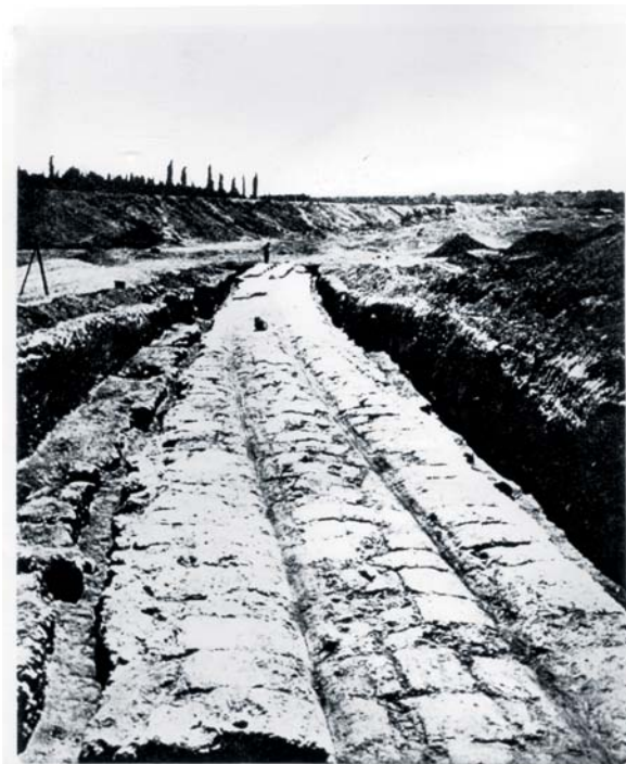
Fig. 6. Vistas de la vía artificial del Diolkos, camino para el transporte de barcos por tierra (hacia 600 a. C.), según N. M. Verdelis (1957). (British Library).
