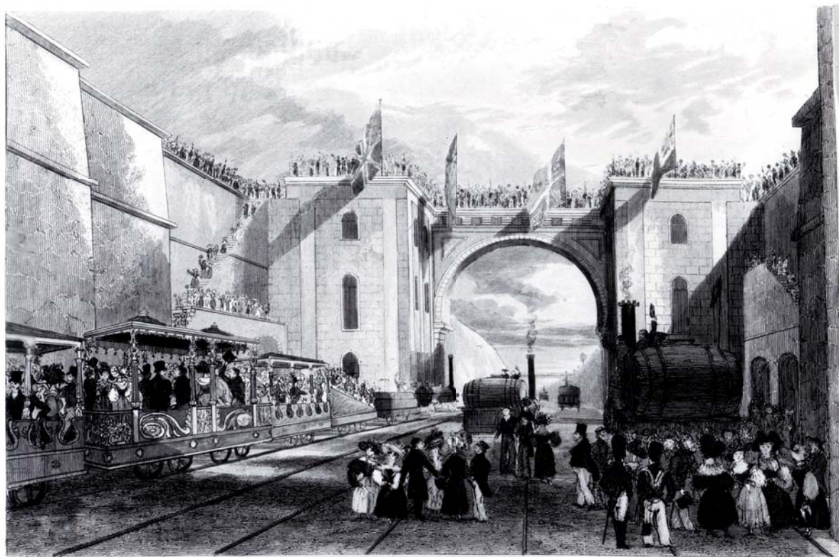
Fig. 211. Inauguración del ferrocarril de Liverpool a Manchester el 15 de septiembre de 1830. La composición situada a la izquierda es la del tren inaugural donde viajaba el duque de Wellington. El lugar es la estación de Edge-Hill vista por el lado opuesto a los túneles. (Science Museum, Londres).
