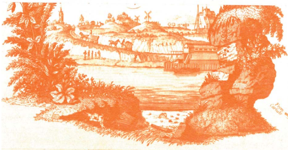
Fig. 72. Camino de madera, en los alrededores de Newcastle, según Gibson (1787). Se aprecian, con toda claridad, la vía principal o descendente y la vía secundaria o ascendente. En la parte derecha, la descarga del carbón desde el cargadero a una barcaza. (British Library).
