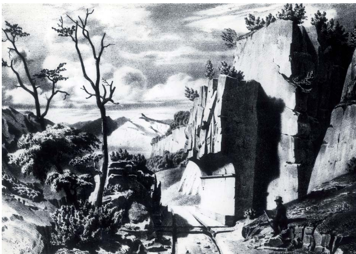
Fig. 5. Rodadas formadas en la roca por el paso de los vehículos. Calzada romana a su paso por el puerto de Lautaret, según Polonceau (1841). (Biblioteca Nacional).
