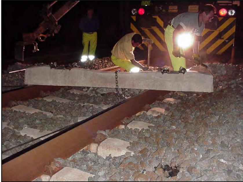
Figura A-VIII.37.- Trabajo nocturno de sustitución de una traviesa en la línea del AVE Madrid – Sevilla, utilizando la grúa de una dresina. Fuente: fotografía realizada por el autor.
