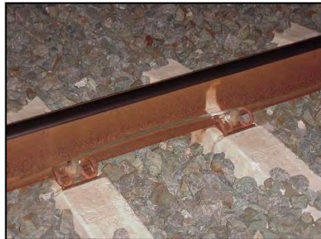
Figura A-VII.7.- Marca de intervalo de 5 m. Fuente: fotografía realizada por el autor.
