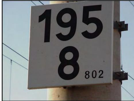
*Figura A-VII.9.- Placa hectométrica en poste de electrificación. Fuente: fotografía realizada por el autor.*
