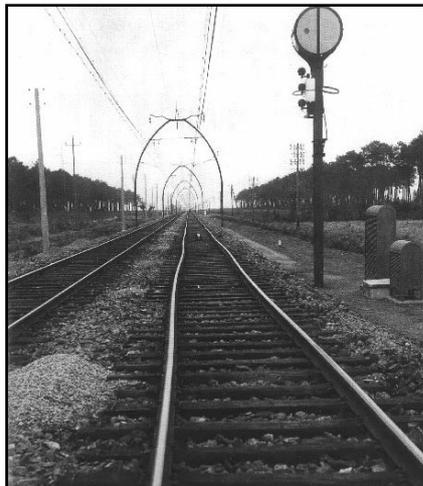
*Figura 5.3.- Estado en que quedó la vía, tras la circulación en 1955 de un tren convencional a 331 km/h en Las Landas (Francia). Fuente: La Vie du Rail (fotografía tomada de López Pita, 2004).*
