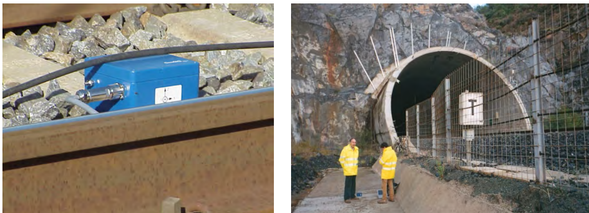
Figura 5-5. Imágenes de los registros sobre traviesa, donde se ve la sujeción del acelerómetro con el cable del sistema LZB (conducción automática) y en la berma de la boca sur del túnel del Valle.
