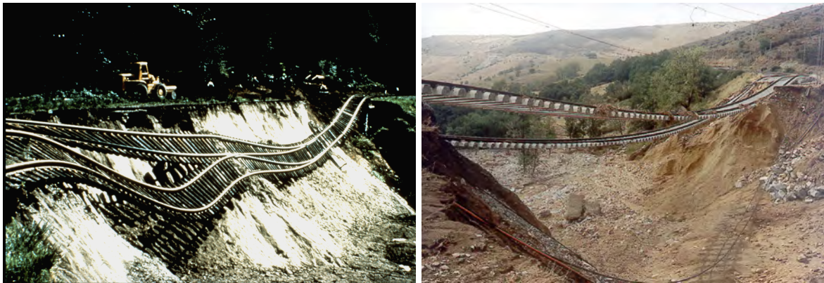
Figura 1-25. Daños producidos en las vías debidos a diferentes orígenes presentando los mismos efectos. La figura de la izquierda corresponde a un desprendimiento de ladera afectando a las vías del ferrocarril producido por el terremoto de Seattle de 1965, la de la derecha se produjo en las proximidades de La Cañada (Ávila), en agosto de 1999, y se debió a una riada que mantuvo cortada la línea Madrid-Ávila durante un periodo de tiempo superior a los tres meses.
