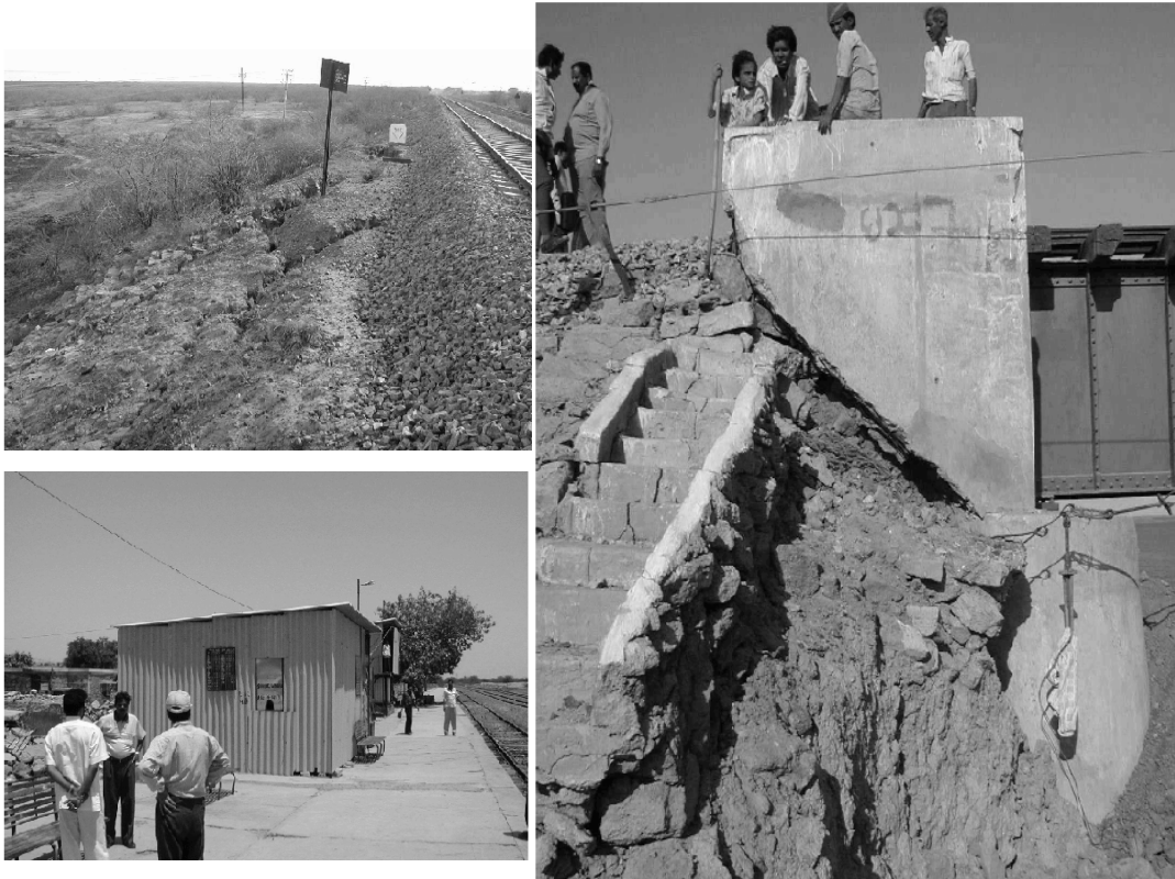
Figura 1-26. Las imágenes de la izquierda muestran los daños en la plataforma y la estación y cabina de enclavamientos provisional instalada tras el sismo. A la derecha se observa el asentamiento en el estribo del puente nº 279. (Byers, 2001a).
