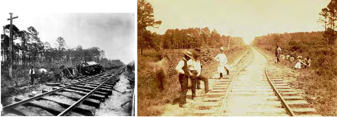
Figura 1-34. Terremoto de Charleston (31-08-1886), magnitud estimada de 6.6-6.9 en la escala de Richter. Descarrilamiento por vuelco del tren producido por el efecto de la interacción directa tren-vía y deformación permanente de la vía por flexión transversal de la misma (pandeo). En la figura de la izquierda se observa que no existe una deformación permanente apreciable en la vía, habiéndose producido sin embargo el vuelco del tren, lo que hace de este caso un daño de tipo I. La figura de la derecha claramente pertenece a daños de tipo II.
