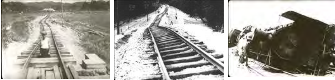
Figura 1-38. Terremoto de Fukui, Japón (28-06-1948), magnitud M_w=7.0 . Las dos imágenes de la izquierda muestran deformaciones de vía conforme al tipo II. En la imagen central se observa la deformación de la vía por efecto de la deformación de la plataforma, no apreciándose deformación de la vía por acumulación de esfuerzos sobre la misma. La imagen de la derecha corresponde al vuelco de un tren por la interacción directa tren-vía en la zona epicentral del sismo (Tipo I).
