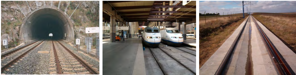
Figura 1-5. Principales tipos de vía: la imagen de la izquierda corresponde al túnel del Valle de la línea Madrid-Sevilla, con la habitual vía balastada; la central a vía con traviesas embutidas en losa de hormigón en la estación de Madrid Puerta de Atocha; la de la derecha corresponde a un tramo de vía embutida en hormigón en el tramo piloto Olmedo-Medina del Campo del GIF (Gestor de Infraestructuras Ferroviarias).
