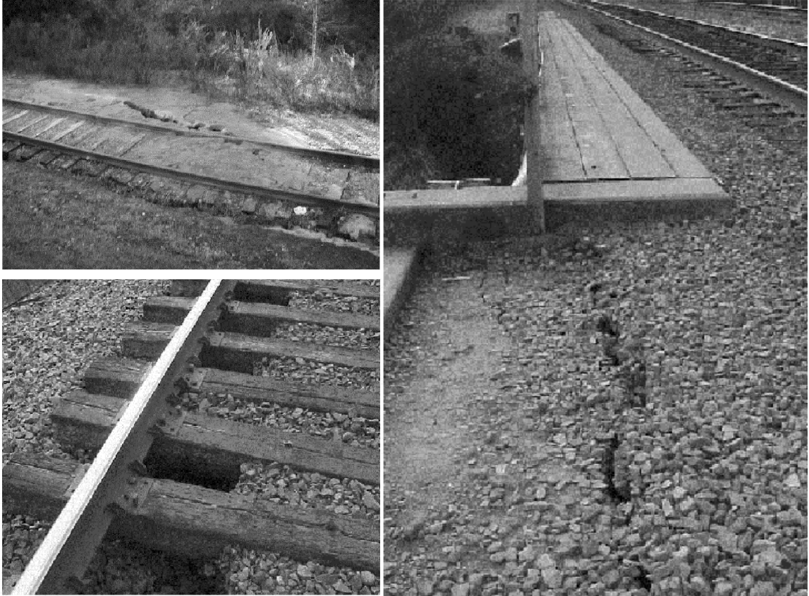
Figura 1-27. Imágenes correspondientes al terremoto de Nisqually del 28 de febrero de 2001: las fotos de la izquierda muestran daños por desconsolidación de la capa de balasto en la vía y por licuefacción de la plataforma. En la de la derecha se observa el asentamiento en el estribo de un puente y la rotura de la plataforma correspondiente a la cuña de transición (Byers, 2001b).
