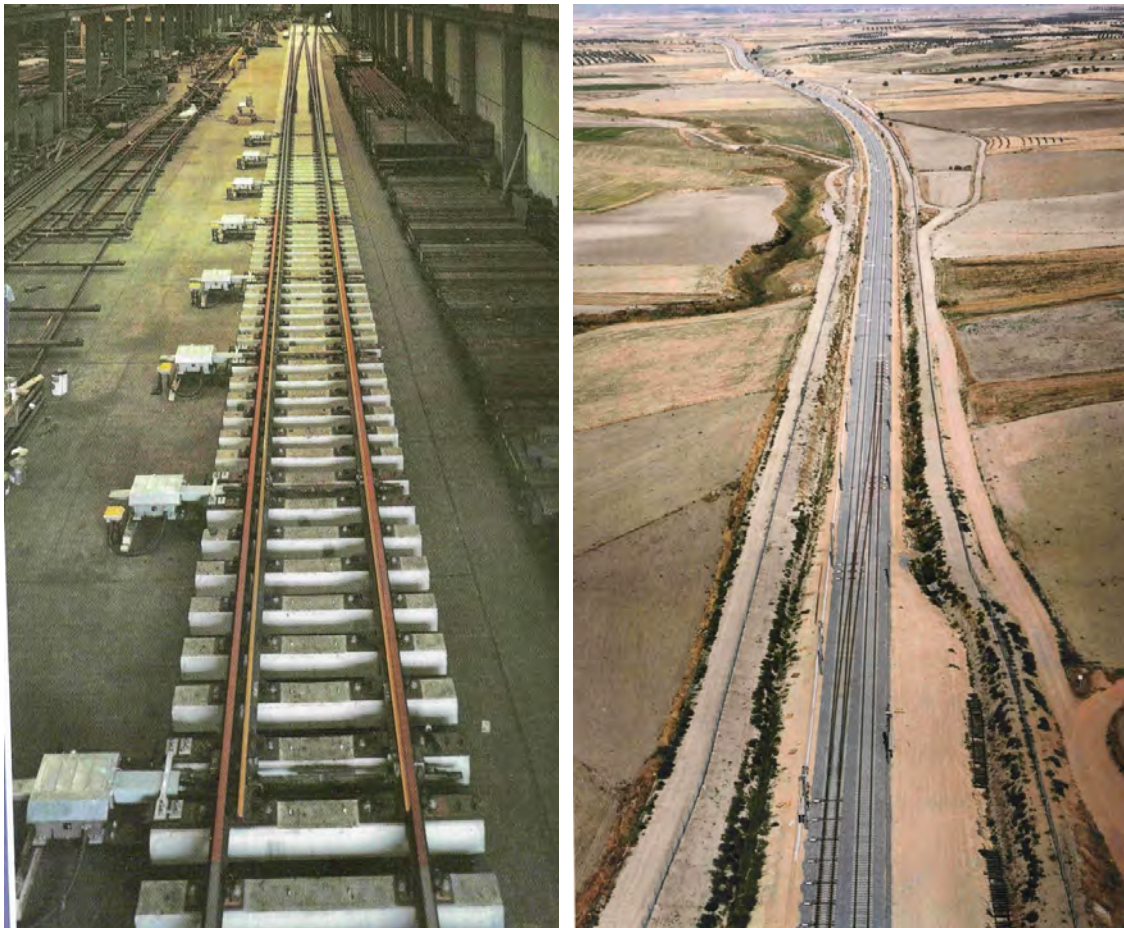
Figura 1-12. Imagen del montaje en taller de un desvío de la línea Madrid-Sevilla. Sus principales características técnicas son: Velocidad de 160 Km/h por vía desviada, máxima aceleración transversal de 0.493 m/s 2 , longitud total de 145'656 m y 11 accionamientos eléctricos (ocho para el desvío y 3 para el corazón móvil). La imagen de la derecha muestra un escape (doble desvío) instalado en vía, siendo su longitud total de cerca de 300 metros (Sánchez Doblado, 1992).
