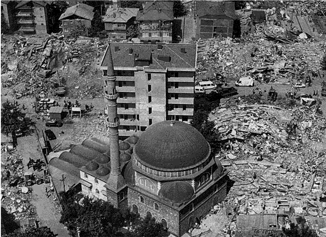
Figura 3-1. Daños producidos en Golcuk por el terremoto de Izmit de 1999. Las estructuras de la mezquita, incluido el minarete, no sufrieron daños, mientras las construcciones circundantes quedaron totalmente destruidas. Las principales causas de este hecho son las condiciones constructivas de los edificios y la respuesta local de los emplazamientos.
