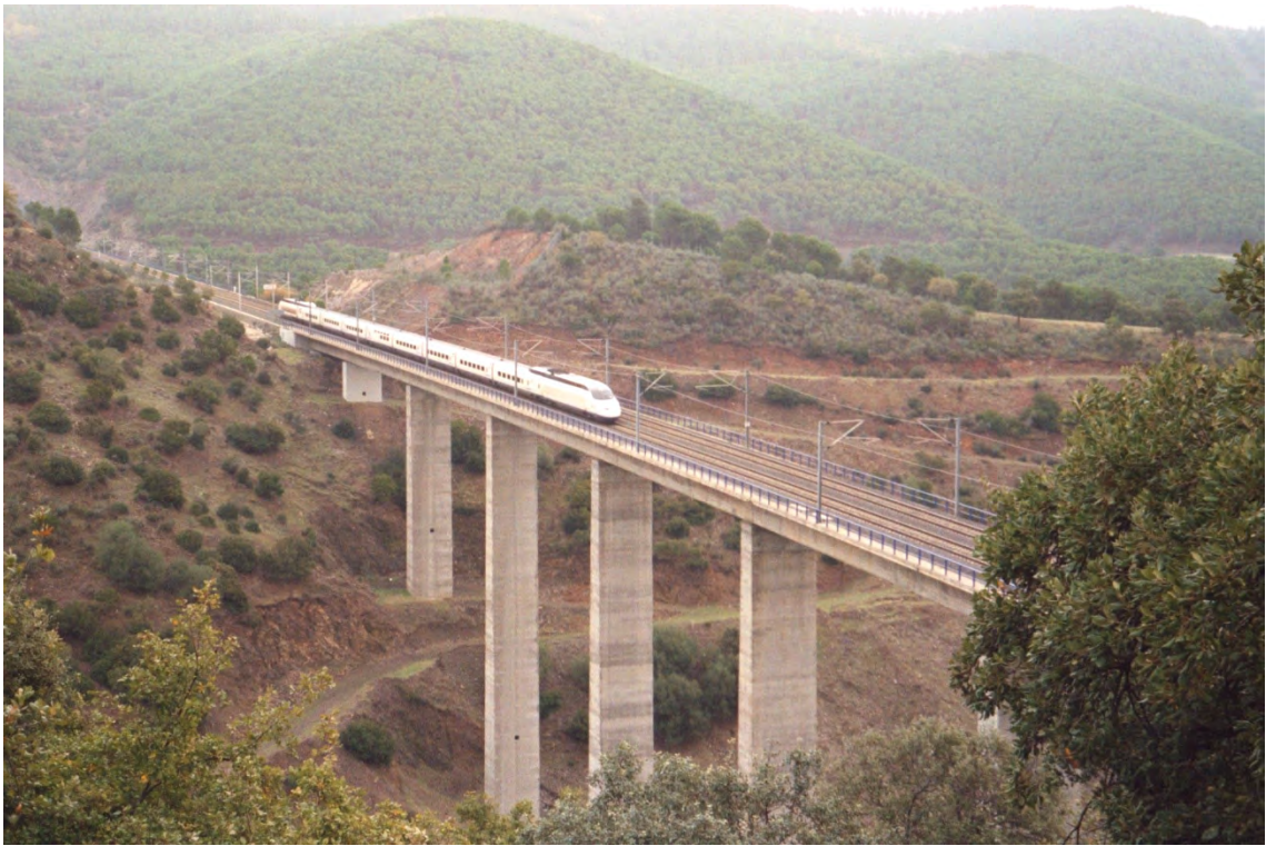
AVE Serie 100 circulando sobre el viaducto de Martindientes (78 m de altura máxima), en la LAV Madrid-Sevilla
