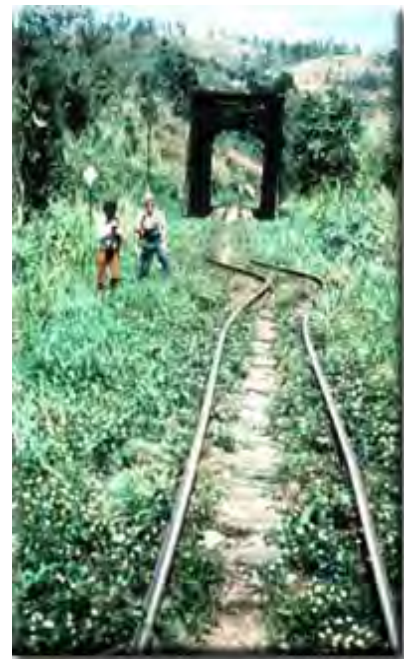
Figura 1-44. Terremoto de Edgecumbe, Nueva Zelanda (02-03-1987), magnitud 7.5. Las imágenes superiores y la inferior derecha muestran daños del Tipo II. La inferior izquierda muestra el vuelco de una locomotora diesel correspondiendo a daños del Tipo I.
