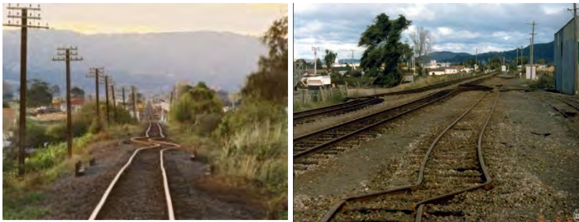
Figura 1-43. Terremoto de Guatemala (04-02-1976), magnitud 7.5. Daños en el ferrocarril correspondientes al tipo II en dos emplazamientos distintos.
