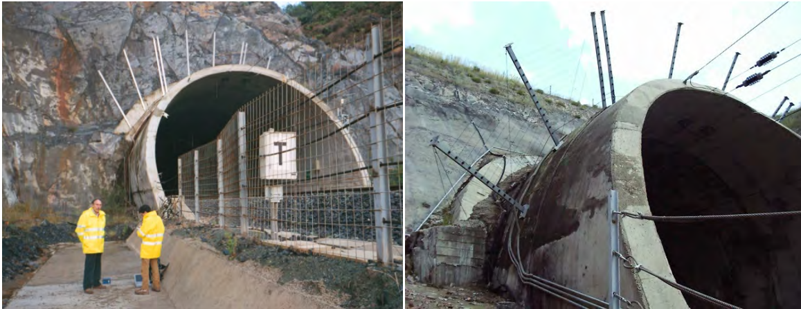
Figura 1-13. Emboquillado en la boca sur del túnel de Piedras Blancas y detalle del sistema de detección de desprendimientos de la boca sur del túnel de Los Caños.
