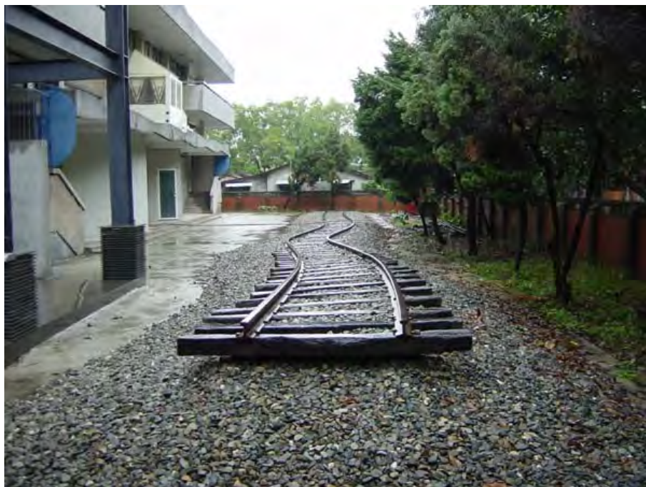
Figura 1-47. Terremoto de Chi-Chi, Taiwán (21-09-1999), magnitud 7.6. Sección de vía retirada con daños de Tipo II.
