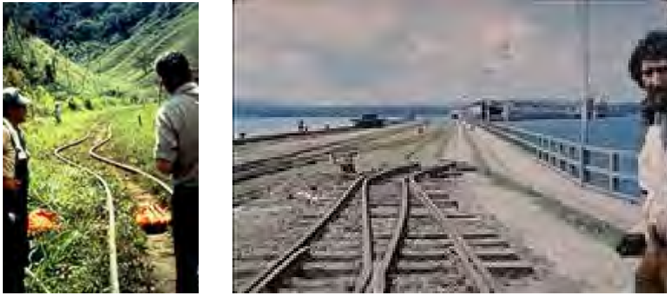
Figura 1-43. Terremoto de Guatemala (04-02-1976), magnitud 7.5. Daños en el ferrocarril correspondientes al tipo II en dos emplazamientos distintos.
