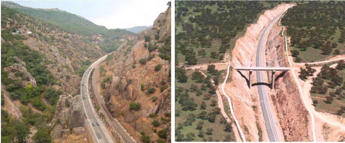
Figura 1-4. Trazados de las líneas Madrid-Sevilla en ancho convencional e internacional a su paso por Sierra Morena. Se observa que si bien los radios de la curva presentada no parecen muy diferentes sí lo es la naturaleza de la explanación realizada: en la figura de la izquierda el trazado sigue el cauce del río y el trazado de la Nacional IV, mientras que en la de la derecha se ve que dicho trazado se ha mecanizado en la roca (zona granítica en Villanueva de Córdoba), modificando de forma importante las condiciones topográficas existentes.
