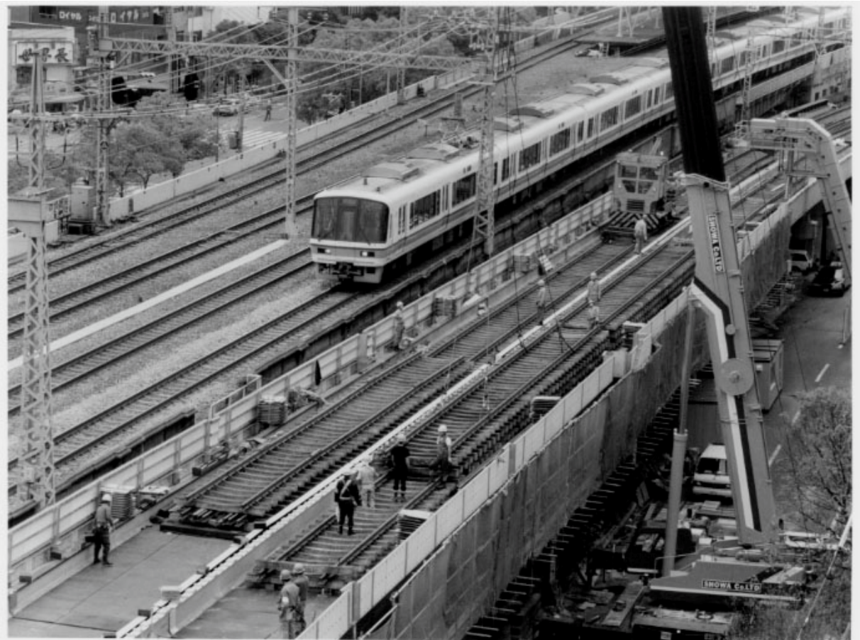
Figura 1-45. Terremoto de Kobe (16-01-1995), magnitud 6.9. Las imágenes superiores muestran el colapso de la vía elevada en un tramo de la Hanshin Expressway (daños Tipo IV), mientras en la inferior se recogen los trabajos de reconstrucción
