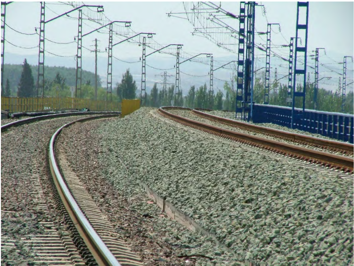
Figura 5-14. Vía mixta en el trayecto Zaragoza-Gogullada, en la que se observa la diferencia entre la capa de balasto de la vía de ancho convencional (izquierda) y la de ancho UIC habilitada para velocidades de 200-250 Km/h. La diferencia de altura entre una capa y otra se sitúa entre 1 y 1.5 metros, lo que modifica de forma importante la respuesta de la vía.
