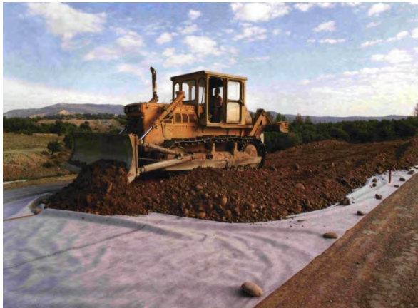
EXTENDIDO DE CAPA DE FORMA SOBRE TEJIDO ANTICONTAMINANTE
