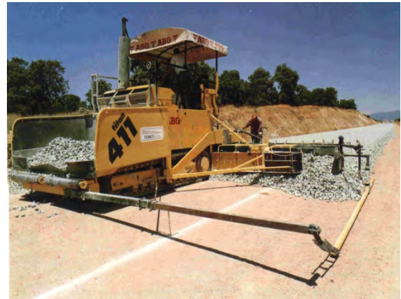
PRIMERA CAPA DE BALASTO (CON EXTENDEDOR)
