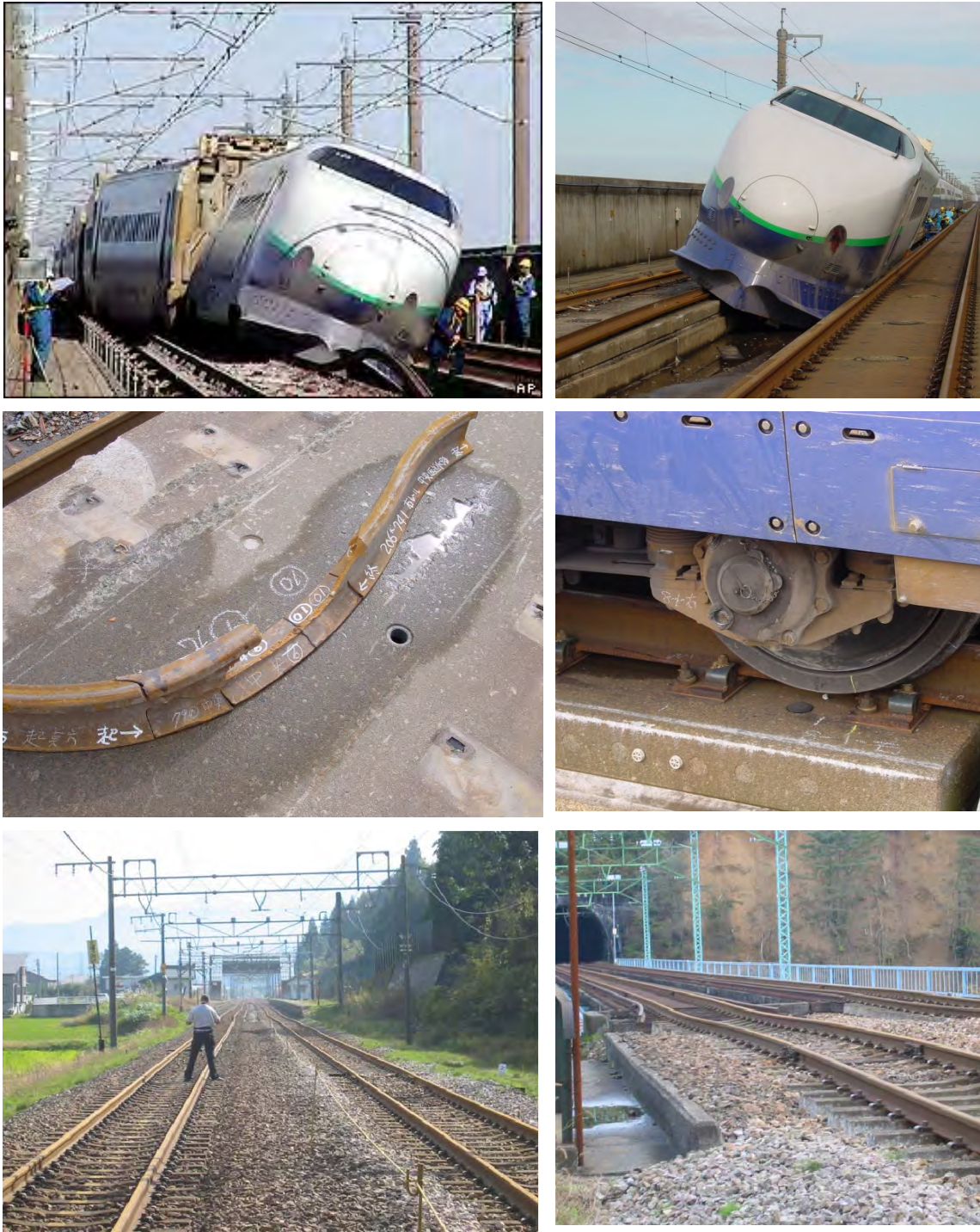
Figura 1-33 . Daños producidos en el terremoto de Niigata de 2004. Las imágenes superiores muestran la situación del descarrilamiento del tren Shinkansen tras la ocurrencia del sismo y tras los primeros trabajos de adecuación de la vía con objeto de proceder a su retirada. Las imágenes centrales muestran una sección de carril deformada y fracturada y un eje de la composición descarrilado y responsable de la rotura de varios cientos de sujeciones a lo largo del tramo de vía recorrido tras su descarrilamiento, habiendo sido éste del orden de 1400 metros (Morimoto et al., 2004). Las figuras inferiores muestran daños en la vía por pandeo lateral en una sección recta de vía y en una cuña de transición en un estribo de un viaducto (Ashford y Kawamata, 2004).
