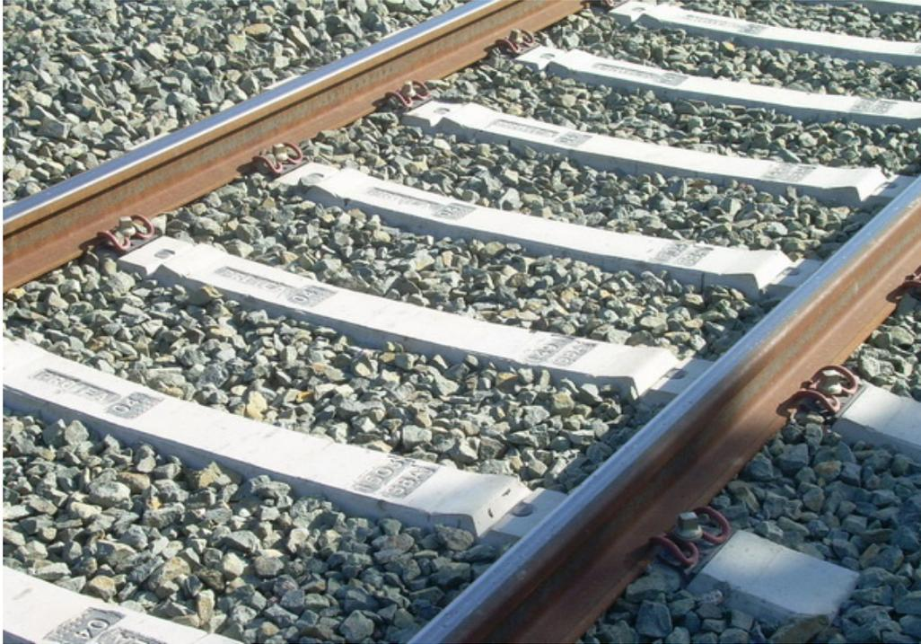
Figura 3.2 Vía convencional, con balasto y traviesas de hormigón monobloque.
