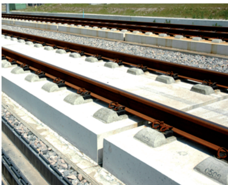
Figura 7. Detalle de Vía en Placa
