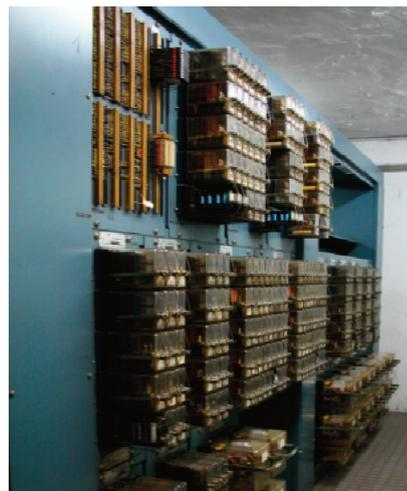
Fig.2. Cabina de relés de un Enclavamiento de Módulos Geográficos
