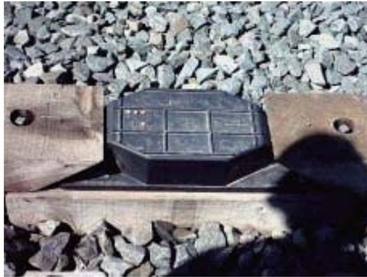
**Figura 12.** Baliza en la caja de la vía<sup>4</sup>
