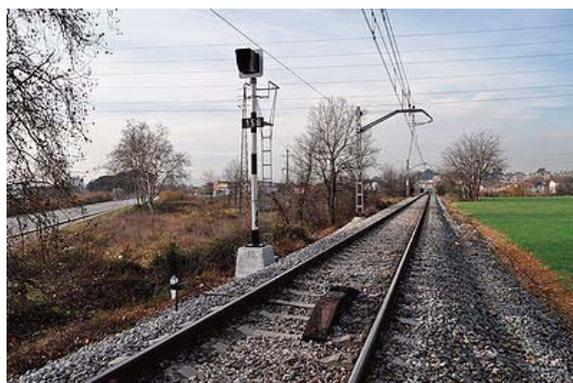
**Figura 14.** Señal de PN dotada de ASFA<sup>6</sup>
