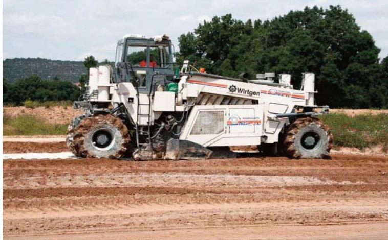
**Imagen 4:** Mezcla de la cal mediante dosificador servodirigido en el tramo de Venta de Baños (Palencia)
