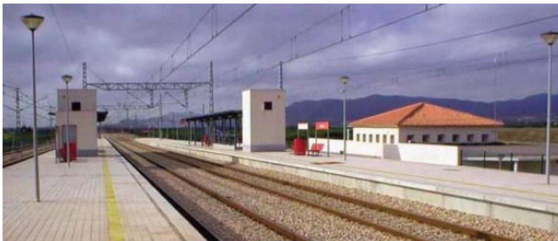
Figura 2. Estación de Almenara en el Corredor Mediterráneo, con señalización en andenes de la zona de seguridad al disponer de andenes en vía general y estar autorizado el paso de trenes a 220 km/h.
