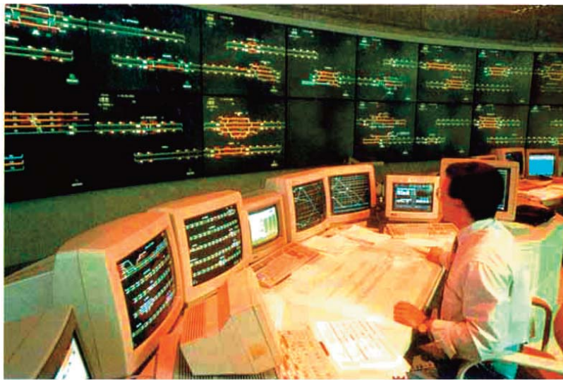
Vista general del puesto de mando Madrid Atocha Fuente: El camino del tren: 150 años de infraestructuras ferroviarias
