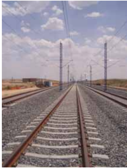
Fig. 8. Los postes entre las vías son frecuentes en líneas urbanas de nueva construcción y en líneas de alta velocidad en las estaciones, como es el caso de Olmedo
