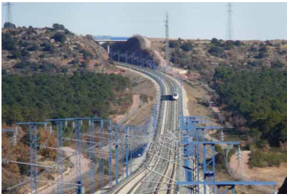
Fig. 7. En las pendientes fuertes el tren pierde energía al frenar para no rebasar la velocidad máxima. Los 25 mm/m de la LAV de Madrid a Barcelona penalizan el consumo de los trenes que van a menos de 235 km/h (Foto AGA)
