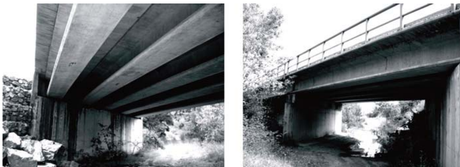
Figura 3. Imágenes del puente Arroyo Bracea II
