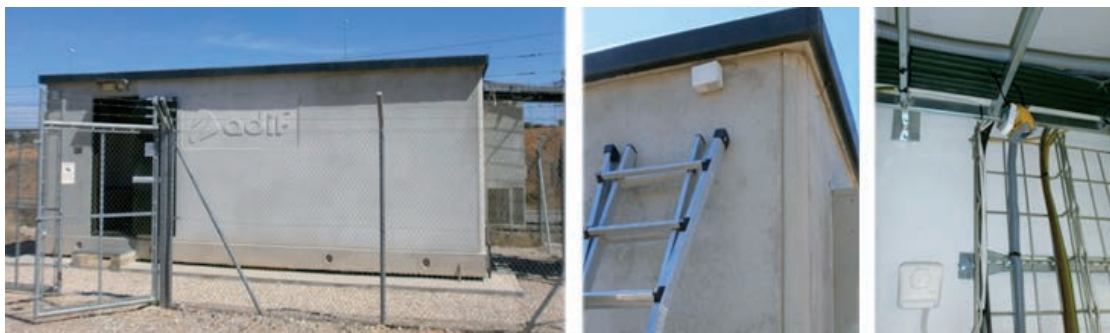
Caseta. Ubicación externa. Ubicación interna.
