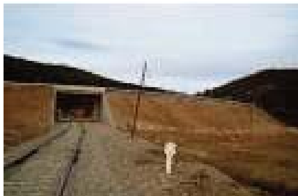
Fig. 4.8. Supresión de un paso a nivel de la clase A y sustitución por un paso superior
