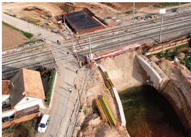
Figura 4.4. Supresión de un paso a nivel y construcción de un paso inferior al lado
