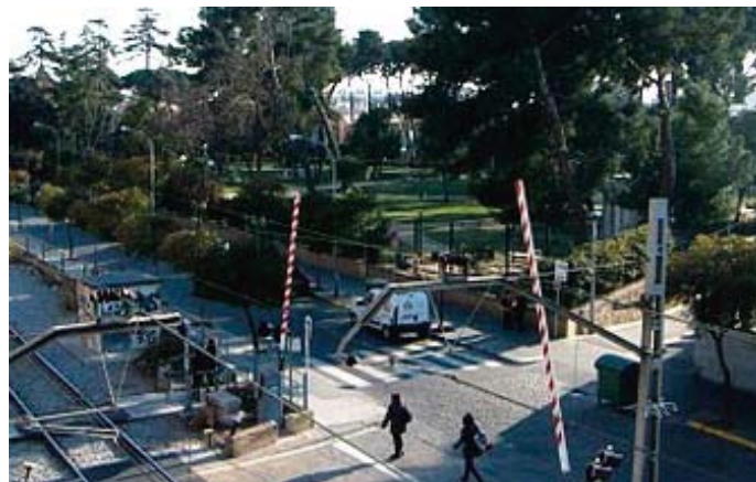
Figura 4.10. Clase C. Dobles semibarreras enclavadas
