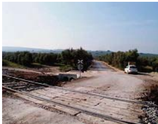
Paso a nivel de clase A, protegido por señales fijas
