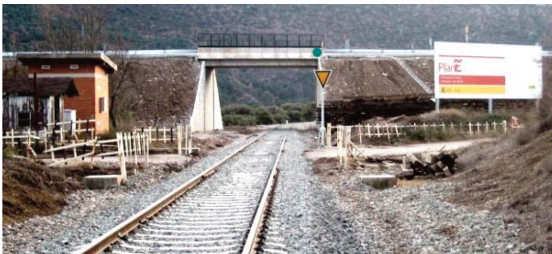
Fig.4.13. Paso elevado en la carretera de La Peña a Jaca para supresión de un paso a nivel
