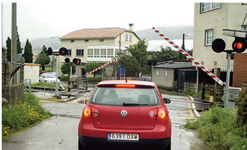
Fig.4.14. Paso a nivel protegido por semibarreras enclavadas con las señales y paso peatonal señalizado.
