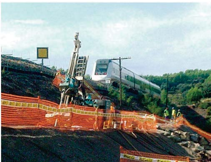
Fotografía 2. Vista del terraplén con tráfico de viajeros durante la realización de los trabajos.
