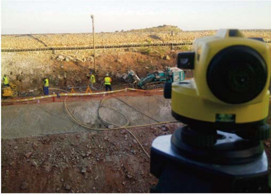
Fotografía 7. Control de nivelación de precisión de la vía.
