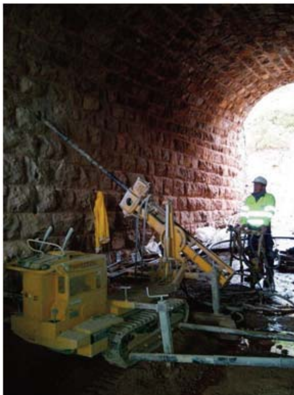
Fotografía 5. Trabajos de perforación desde tunel existente bajo terraplén.
